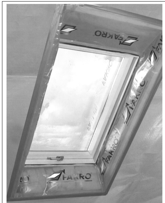
Рис. 2. Внутренний пароизоляционный оклад XDS
