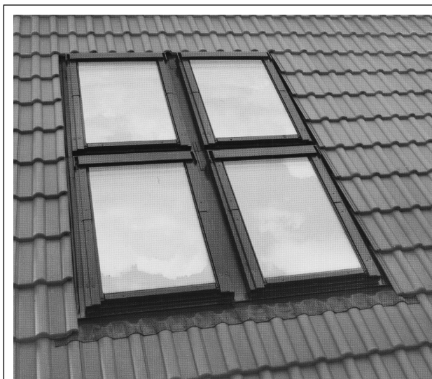
Рис. 5. Система изоляционных окладов «Комби»
