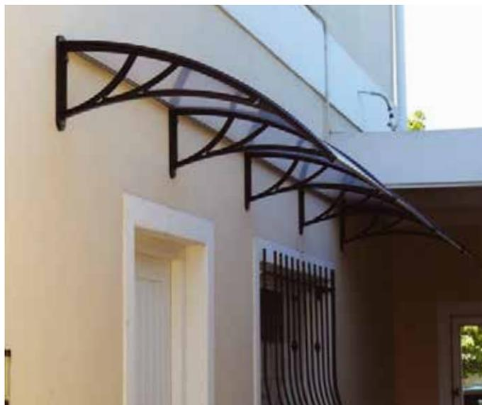
Защитные козырьки из поликарбоната – специальная конструкция, которая устанавливается над входными дверями, окнами и балконами, гаражными воротами, а также кондиционерами. Выполняет не только защитную функцию во время дождя, снега или града, но и придает новые очертания экстерьеру здания. Козырьки изготовлены из качественного и долговечного материала, благодаря чему обладают высокой прочностью, устойчивостью к ветровым нагрузкам и воздействию УФ-лучей.
